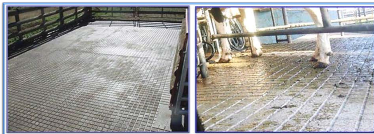
Рисунок 4.5 - Варианты продольной и поперечной насечки
