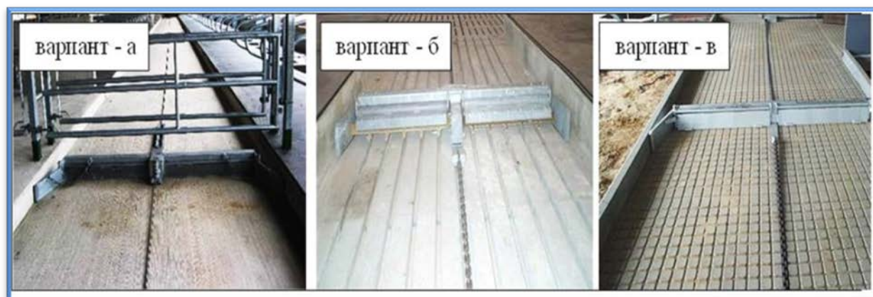
Рисунок 4.3 - Варианты конструкции пола кормонавозных и навозных проходов
