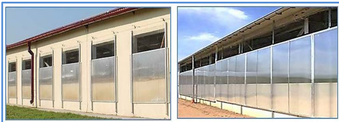
Рисунок 10.8 - Схема установки подъемных окон из поликарбоната
