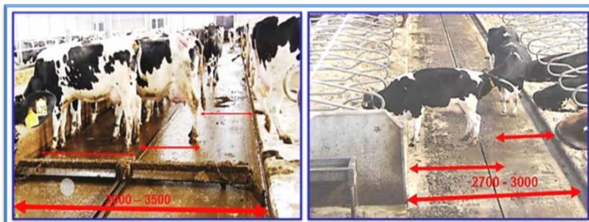
Рисунок 4.2 - Примерная планировка кормонавозных и навозных проходов
