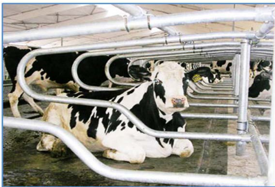
Рисунок 4.13 - Конструирование разделителей, обеспечивающее свободное пространство для головы коровы в передней части бокса
